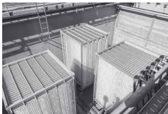
Textile Bioreaktoren Sanierung 2017
