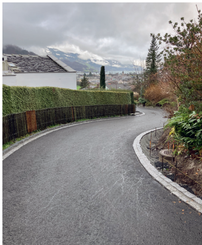
Alte Dorfasse, Situation nach dem Einbringen der Tragschicht
