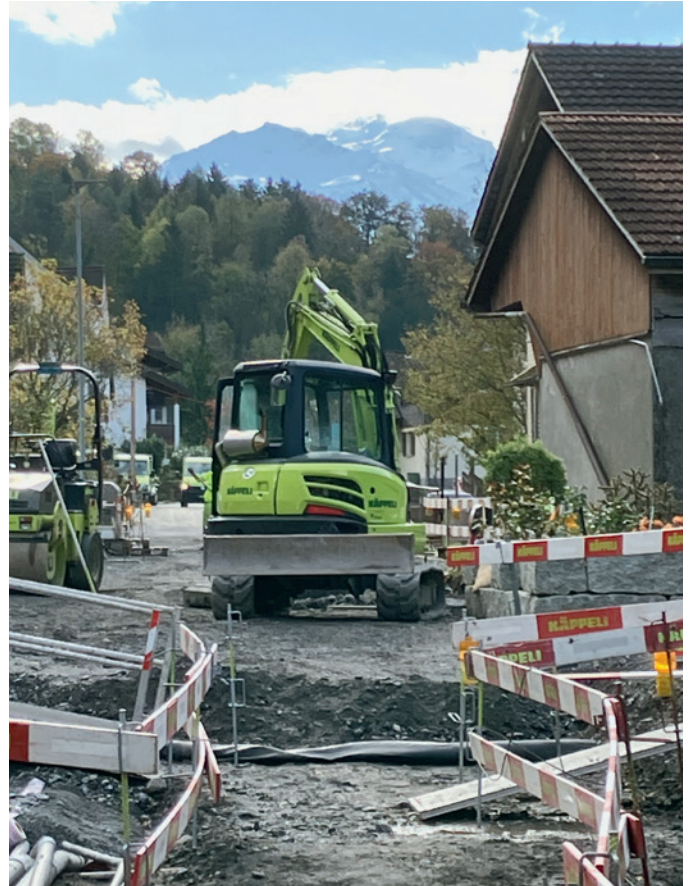
Allmendstrasse Berschis, Grabarbeiten Werkleitungen
