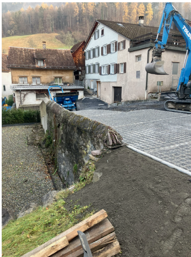
Kirchstrasse, Situation vor dem Einbringen der Tragschicht
