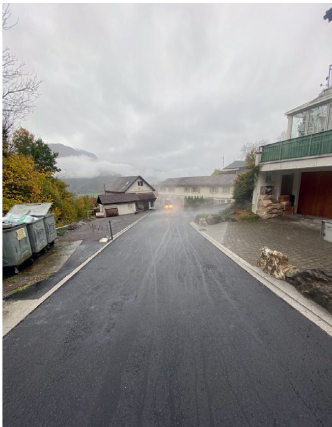
Töbeliweg, nach dem Einbau der Tragschicht
