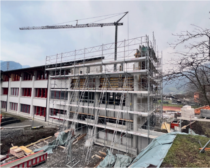
Erweiterung Schulhaus Camilun, Rohbau
