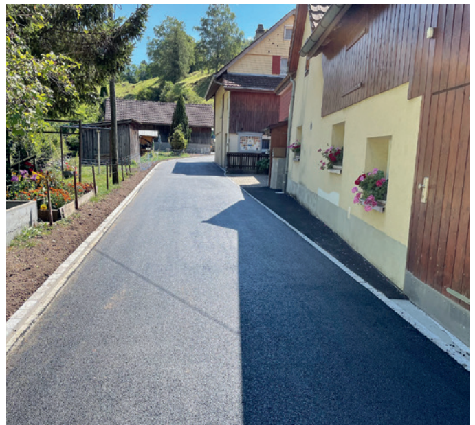
Sanierung Bachsandweg Berschis
