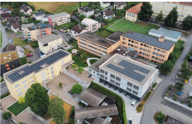
Obstadtschulhaus, Lernhaus C, mit neuer PV-Anlage im Zentrum
