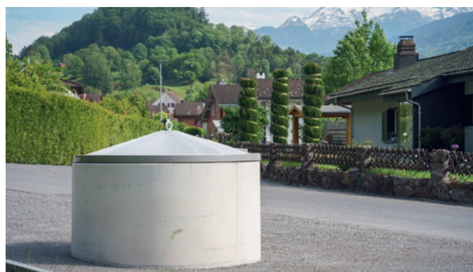
Der neu erstellte Unterflurcontainer an der Hanfländerstrasse
